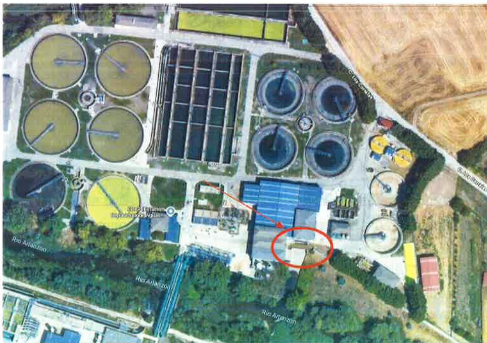
Imagen 2. Localización de las obras en el colector de entrada general.
