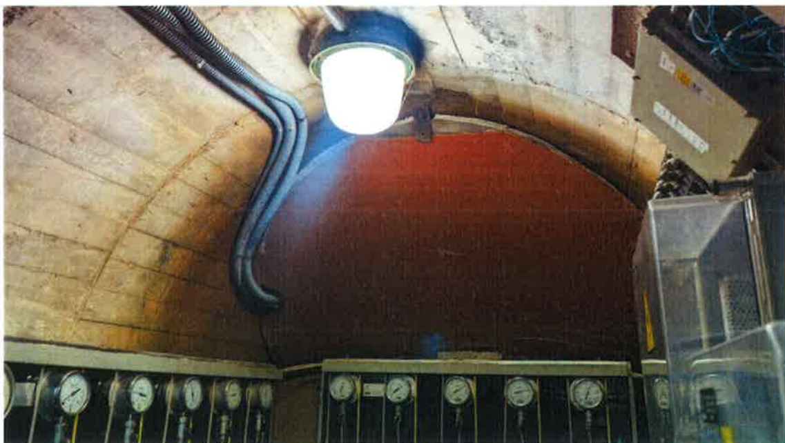
Chimenea de ascensión hasta coronación de la presa.
