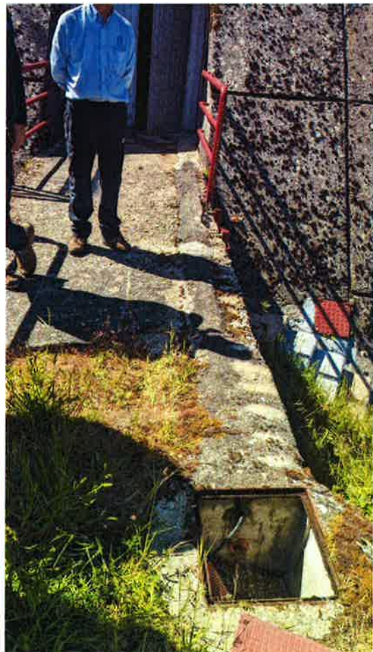
Arqueta y canalización existentes en el exterior de la presa. Continuidad canalización hasta poblado presa.
