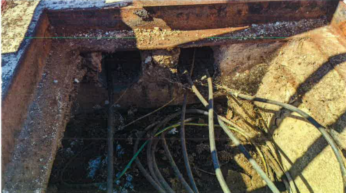
Arqueta existente en la coronación de la presa de Arlanzón.
