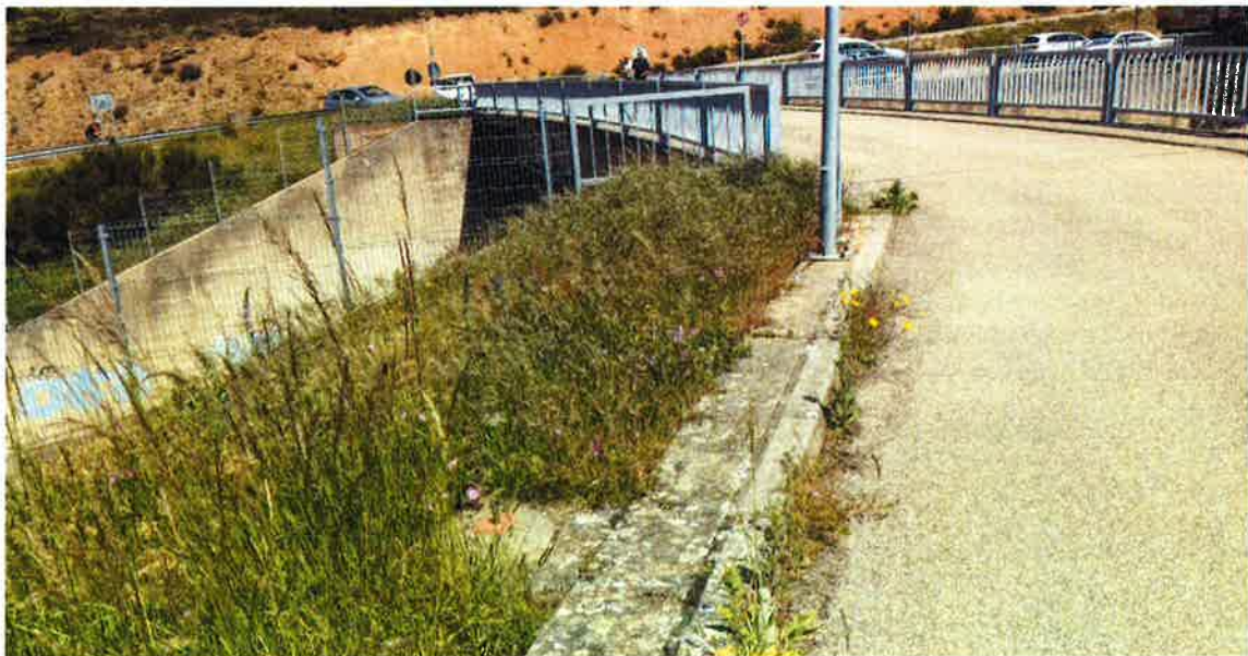
Vista del paso sobre el aliviadero.
