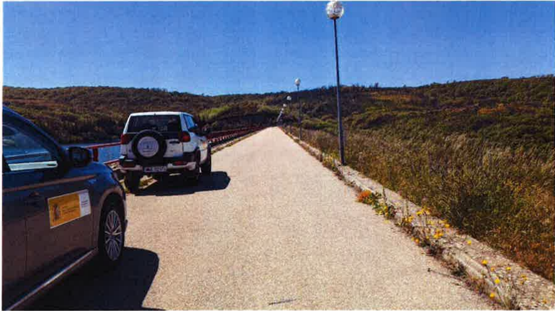
Coronación de la presa de Úzquiza. Acera existente.
