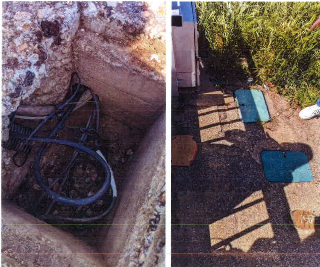
Arqueta inicial y final del paso sobre aliviadero.
