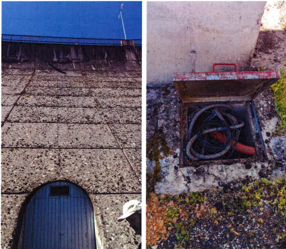
Punto de entrada y arqueta de salida de las canalizaciones existentes en coronación y pie de presa.
