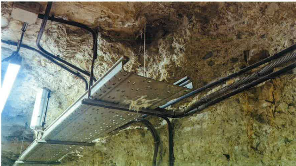
Bandeja existente en las galerías.
