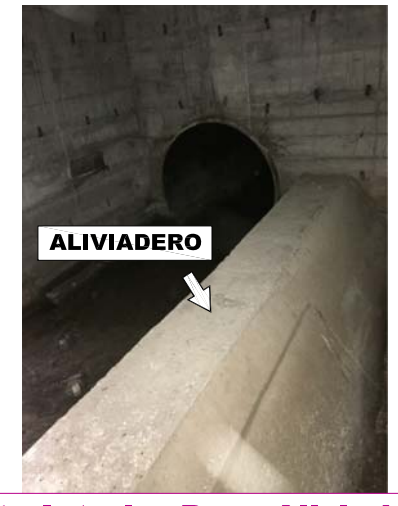
Foto Interior Pozo Aliviadero
