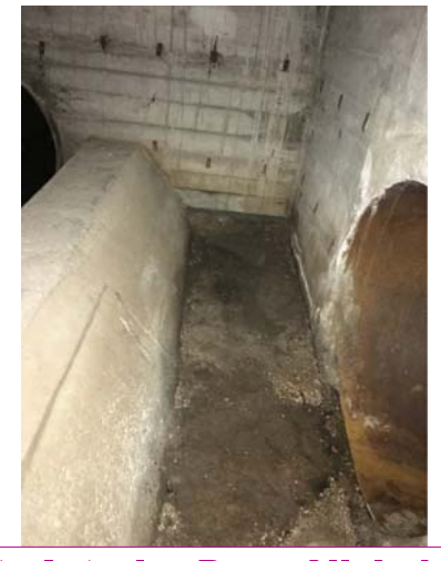
Foto Interior Pozo Aliviadero
