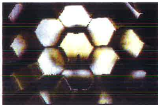
Foto 1: (1) Recogida de agua tratada - (2) Módulos lamelares
