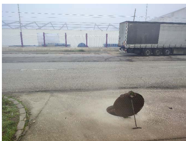
Pozo de registro existente 1.8
