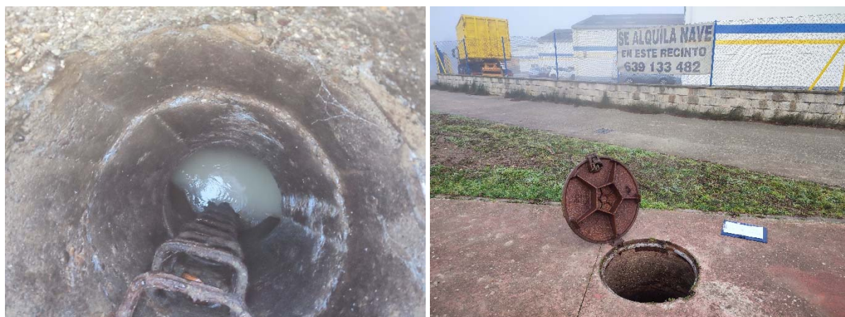
Pozo de registro existente 1.1
