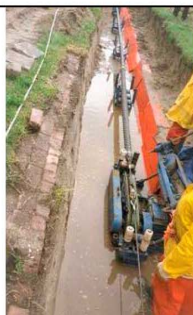
Cables enterrados directamente en el terreno
