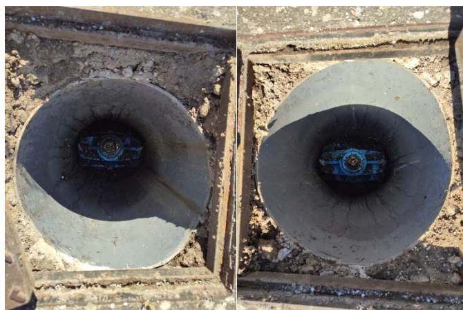
Arquetas existentes nº 7.
