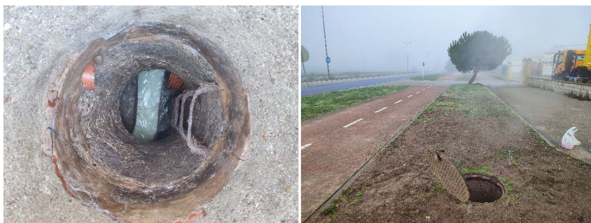
Pozo de registro existente anterior al 1.1
