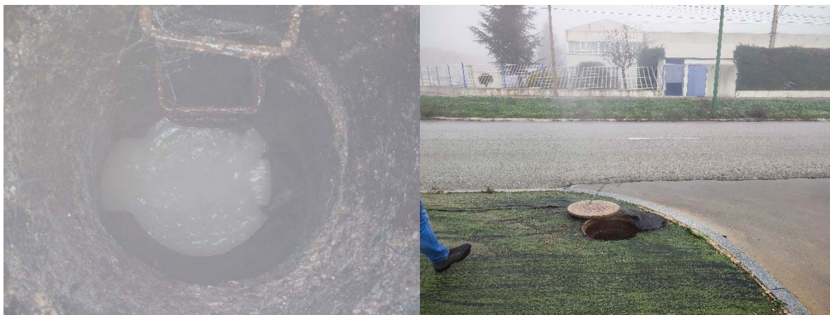
Pozo de registro existente entre el 1.12 y el 1.13
