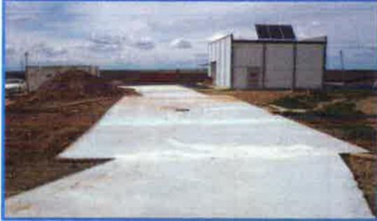
Entre las 2 naves se encuentra la zona habilitada para limpieza de las máquinas y camiones, realizada mediante una solera de hormigón de 20 cm de grosor, sobre una capa de zahorra artificial perfectamente compactada.
