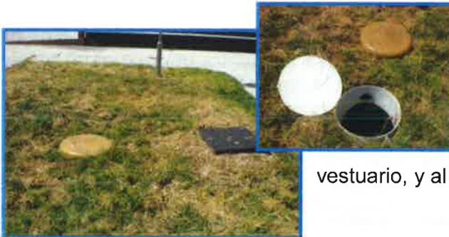
El suministro de agua potable se realiza mediante un grupo de presión situado en un depósito enterrado de poliéster reforzado (de 4.000 l de capacidad), que impulsa el agua a través de un tubo de polietileno de 32 mm conectado con el edificio de oficinas y vestuario, y al que se aporta agua de forma periódica.
