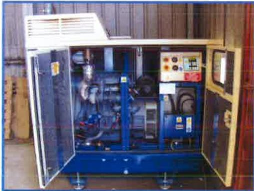
La planta dispone dentro de la nave Almacén de un grupo electrógeno de de la marca ELECTRA MOLINS de 40 kvA.
