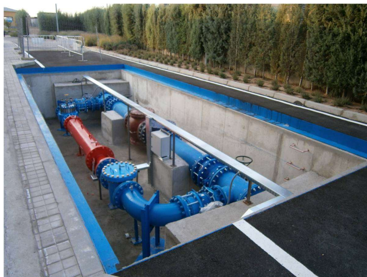
Imagen 3: Turbogenerador PERGA de 100 kW instalado a la entrada de la ETAP de Griñón (España)
