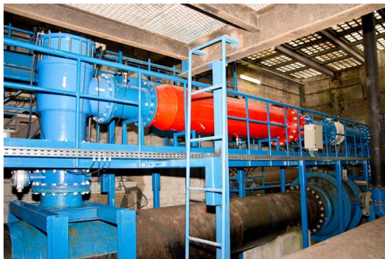
Imagen 2: Turbogenerador PERGA de 60 kW instalado a la entrada del depósito de Plaza de Castilla (Madrid, España)
